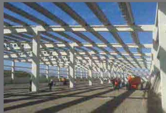
Centro de Distribución Transaco - Noviciado
