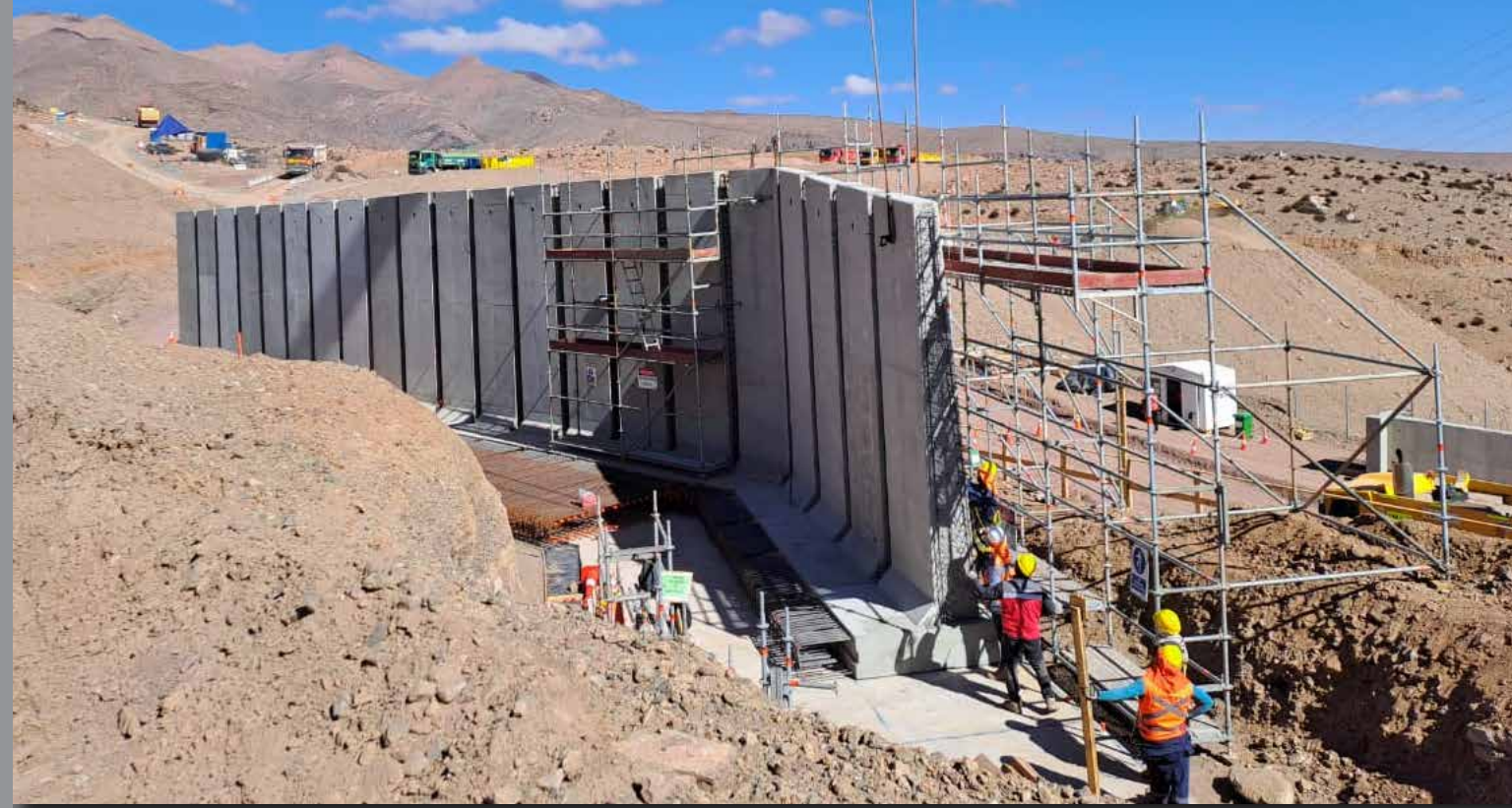
Muros de Contención Techint
