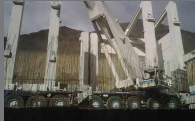
Subestación Andina Codelco
