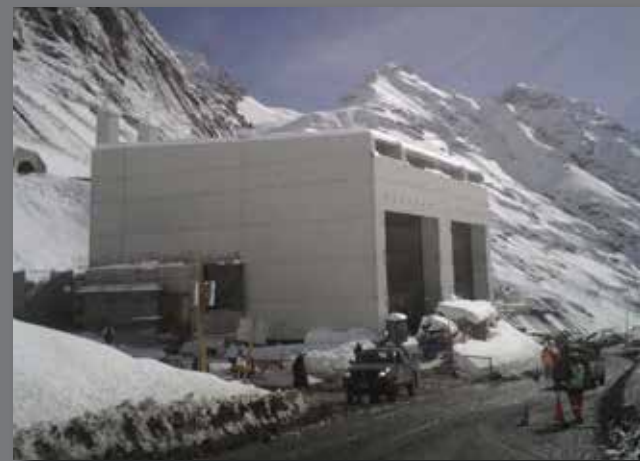
Subestación Andina Codelco
